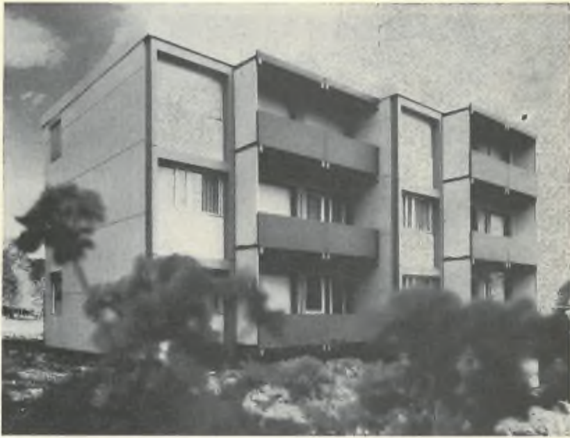
Casa d'appartamenti ad Auw Arg.
